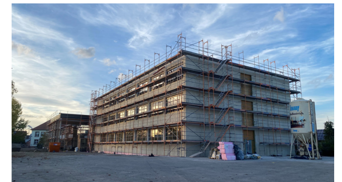
Baufortschritt im Oktober 2022
