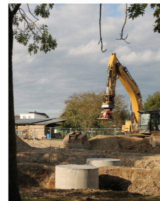
Beginn der Rohbauarbeiten im Oktober 2021
