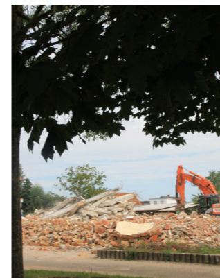
Abriss Alte Rheingießhalle im August 2021
