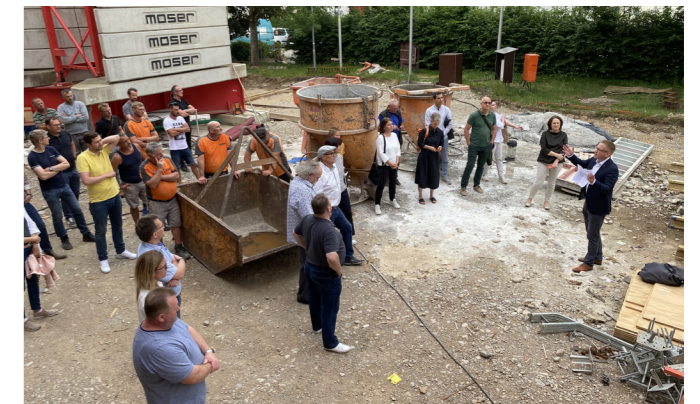
Der Rohbau steht, das Dach ist errichtet, Spatenstich für das neue Schulgebäude am 22. Mai 2022
