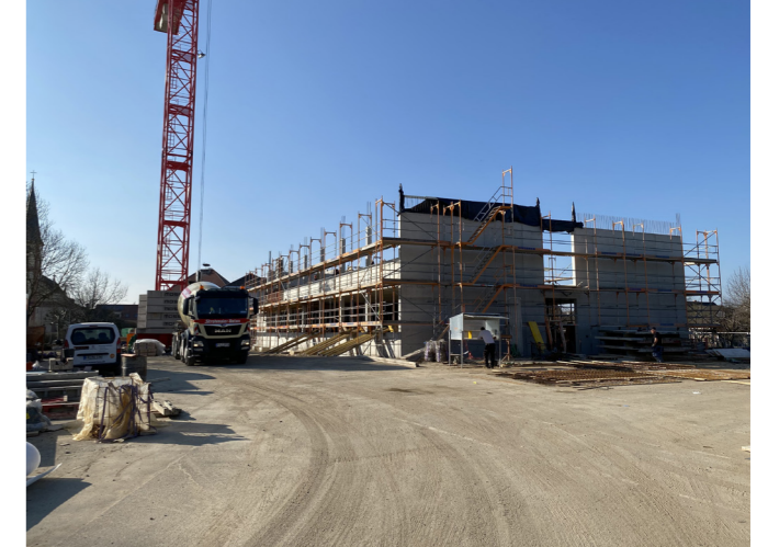
Rohbau im März 2022
